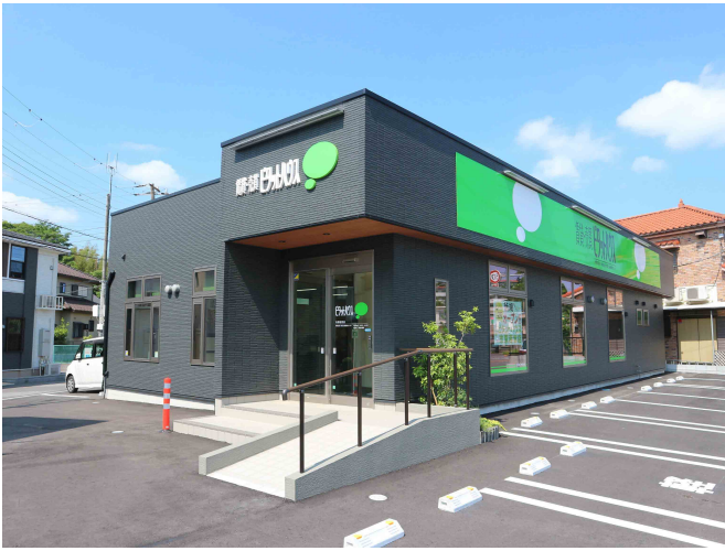
若宮団地入口にある令和4年に完成した新社屋です
